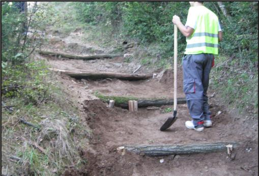
Санирање на патека на Водно (расчистување, проширување на патеките, пополнување на создадени бразди, изработка на одводи, скалила и потпорни сидови. Сето тоа е направено со користење на ресурси од терен, како што се камења, и стебла кои се паднати или веќе не се живи).
